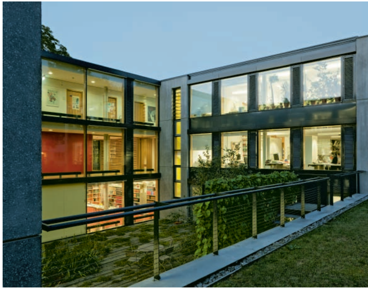
6-8. Blick in den abgesenkten Lesegarten auf der Südwestseite an der Leichhardtstraße.
